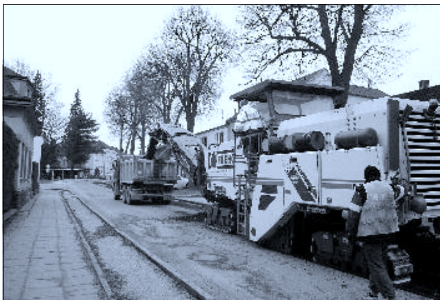
2. část rekonstrukce ulice 28. října začala v pondělí 18.3.2013 frézováním asfaltového povrchu vozovky
